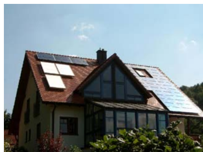
Therm. und Photovoltaikanlagen
