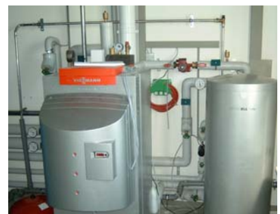
Heizungsanlage (Gas)
